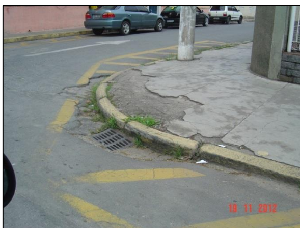
Figura 29 – Boca de lobo localizado no distrito Sede
