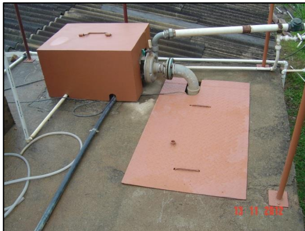
Figura 18 –Reservatório semienterrado anexo a ETA do Horto Florestal – Vista 2
