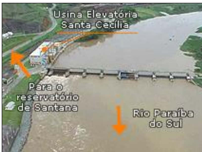
Figura 4 – Usina Elevatória de Santa Cecília
