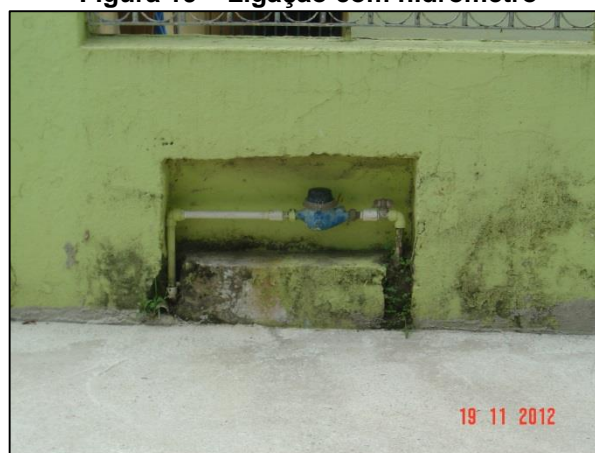
Figura 19 – Ligação com hidrômetro
